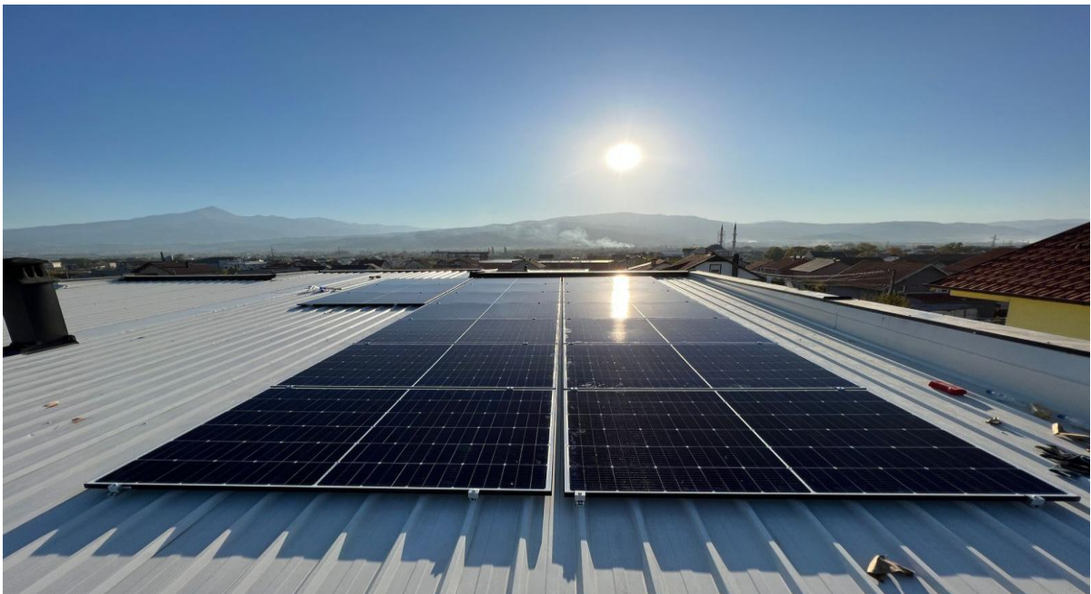
Fig. 3.3 Pamje nga realizimi i një gjeneratori për vet-konsum Person Fizik 7 kW.
