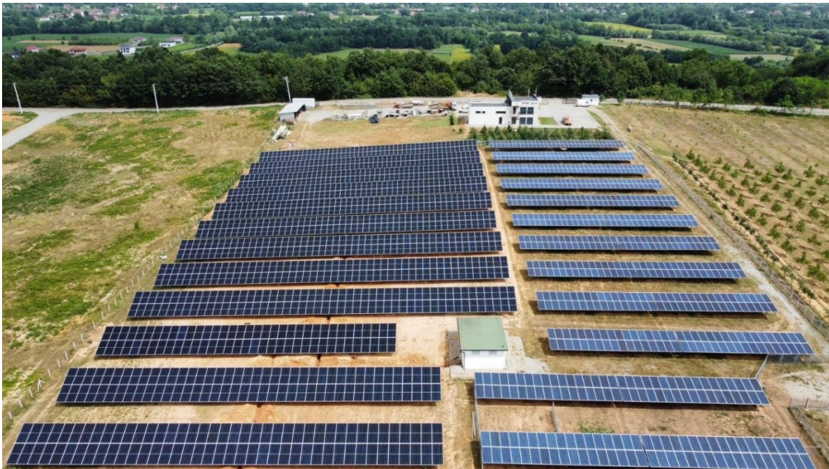
Fig. 3.1 Pamje nga realizimi i një gjeneratorit Solar – Eling Grup SH.P.K. Kapaciteti 1000 kW, Pejë
